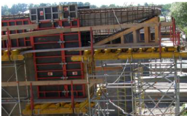
Рис. 2 Рабочее армирование обоймы. Установка опалубки
