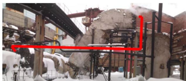
Рис. 2 Схематично изображена ось (выделена красным цветом) одного из вновь монтируемых воздуховодов от дутьевого вентилятора к планируемому месту установки нового теплообменника по одной стороне котла.
