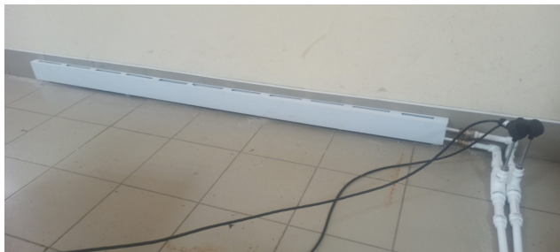
Рисунок 2 - Теплый плинтус с датчиками температуры на вводе и на выходе
